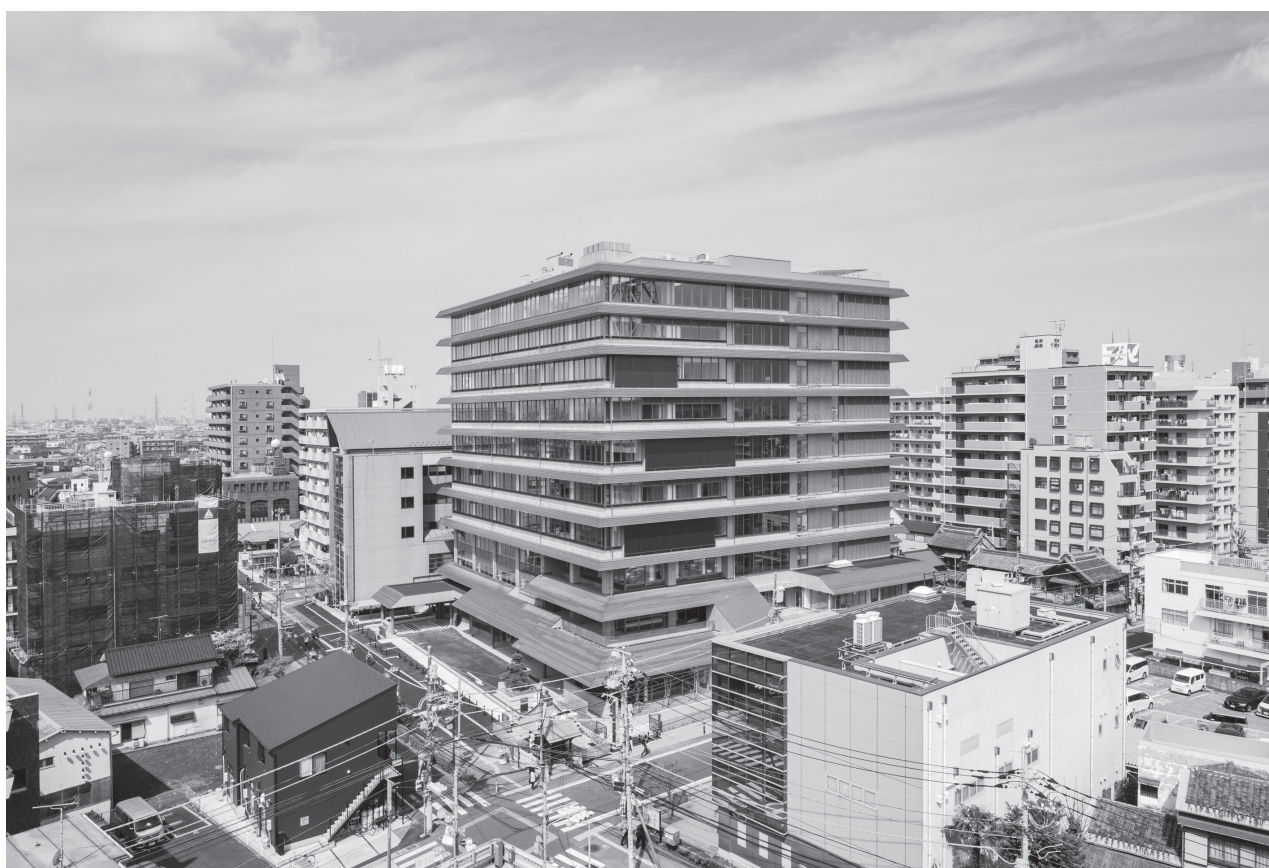
草加市役所新庁舎(新庁舎左側に隣接する5階建ての建築物が西棟)
