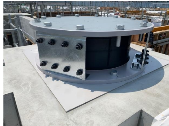
免震装置（積層ゴム）
