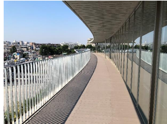
3階 庇を兼ねたテラスと南面ガラス窓
