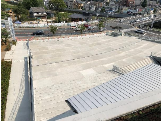
グランドテラス（人工地盤）
